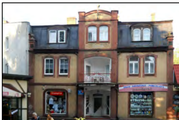
Budynek naprzeciw kina – po prawej stronie dawna cukiernia
